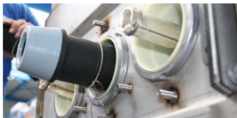
Figure 12: Isolation du jeu de barres posé
