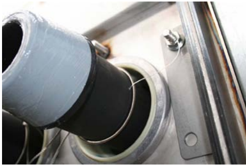
Figure 13: Connexion de mise à la terre
