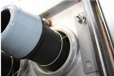
Figura13: Conexión de puesta a tierra
