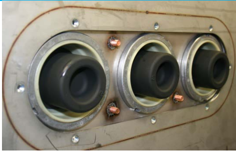
Figura16: Conectores aisladores facticios
