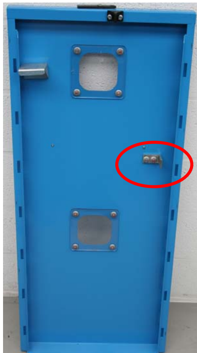
Foto 1: Deur geschikt voor DF-A cel uitgerust met arc-killer
