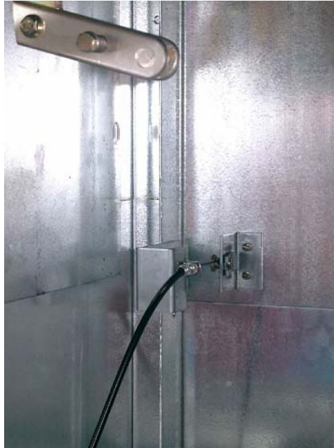
Foto 9: Kabelaansluiting kabelcompartment
