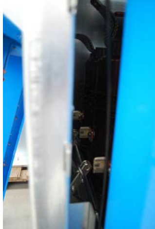
Foto 15: Aardmes arc-killer wordt uit aardingsblok gelicht
