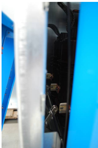
Foto 7: Aardmes arc-killer wordt uit aardingsblok gelicht
